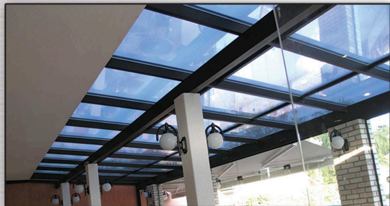
Cobertura com isolamento térmico em vidro duplo fumê com película de segurança refletiva prata.
