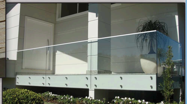
Guarda corpo com vidros fixados com grapas laterais.
