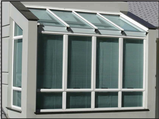
Janela de alumínio Maxim-ar com bandeira inferior fixa e cobertura de vidro temperado.
