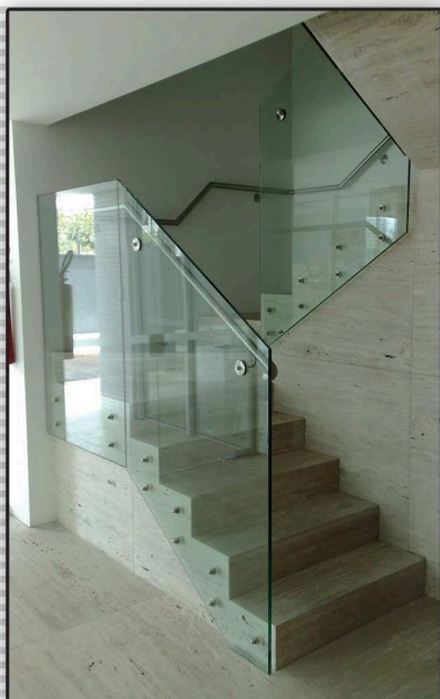
Guarda corpo de vidro temperado com fixação em botons de inox.
