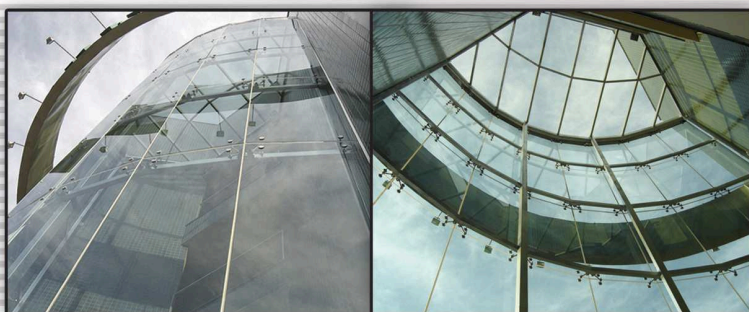
Fachada de vidro com sistema de fixação spider.
