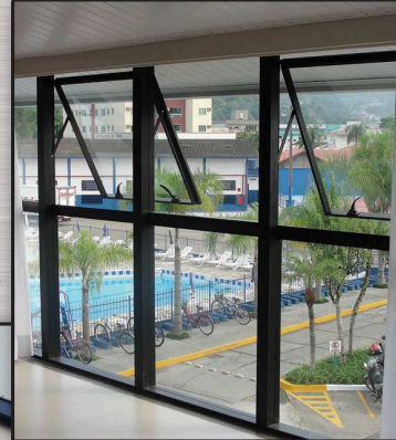
Fachada pele de vidro encailhado com vidro laminado incolor.
