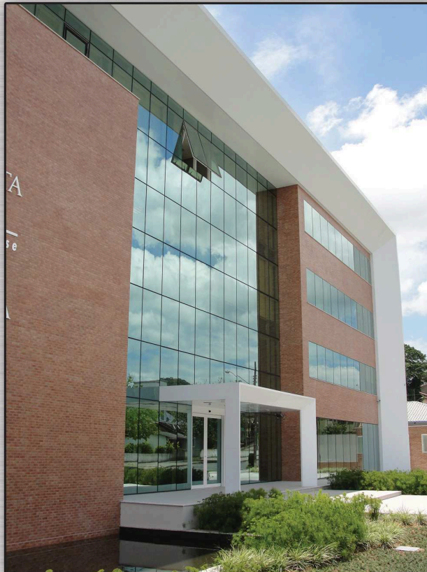
Fachada linha Cittá Due com vidro laminado refletivo verde.
