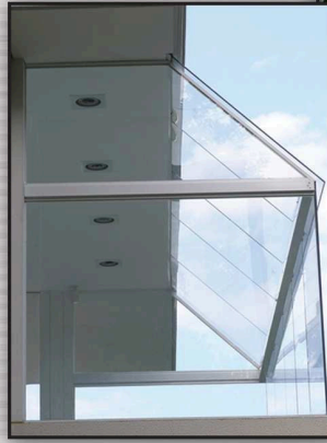
Bay-window 90° de vidro temperado incolor fixa com cobertura de vidro temperado.
