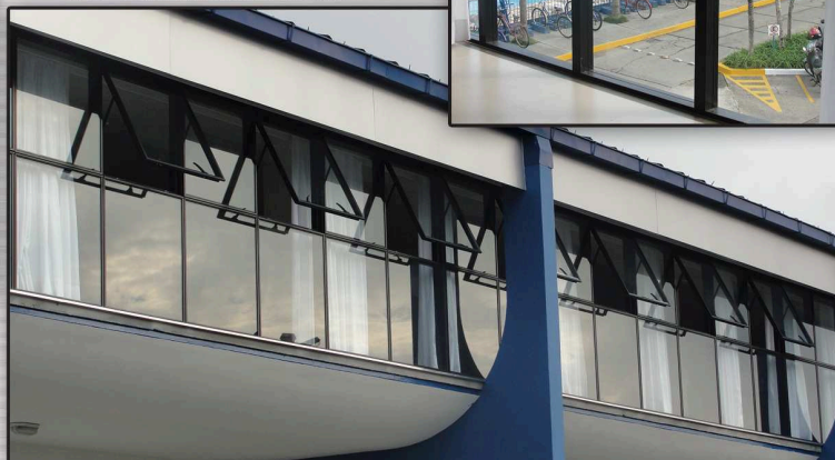
Fachada pele de vidro encailhado com vidro laminado incolor.
