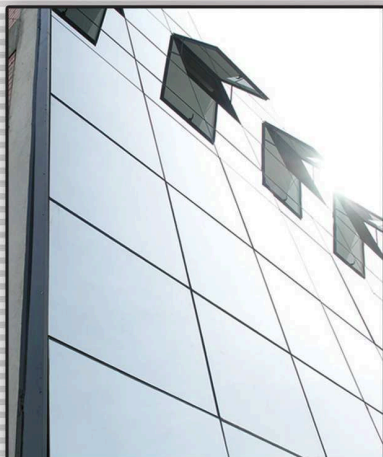
Fachada pele de vidro com sistema estrutural Glazing.
