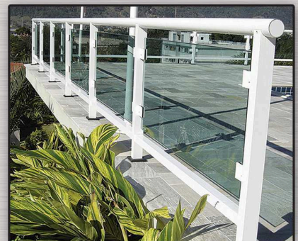
Guarda corpo com vidros fixados com grapas laterais.
