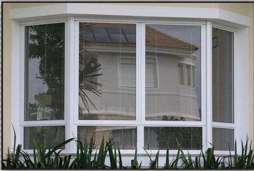
Bay-window 135° composta por janela de alumínio Maxim-ar 4 folhas com bandeira inferior fixa.
