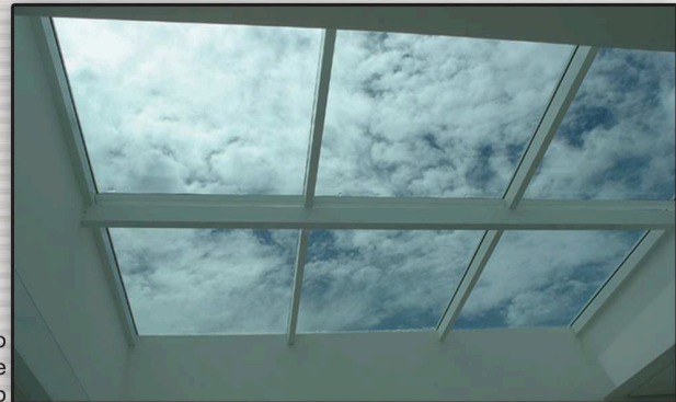
Cobertura com isolamento térmico em vidro duplo fumê com película de segurança refletiva prata.
