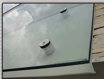
Guarda corpo de vidro temperado com fixação em botons de inox.
