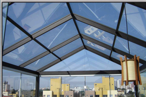
Cobertura de vidro sobre estrutura de alumínio com fechamento das laterais em vidro temperado incolor.
