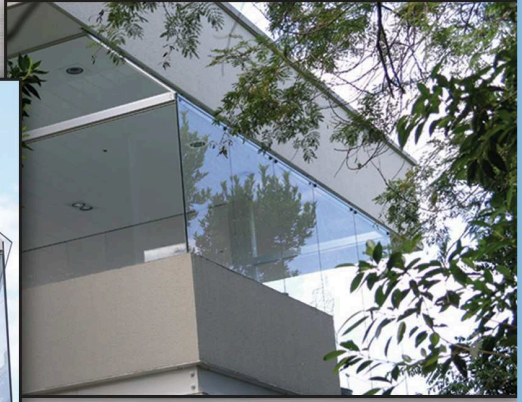
Bay-window 90° de vidro temperado incolor fixa com cobertura de vidro temperado.
