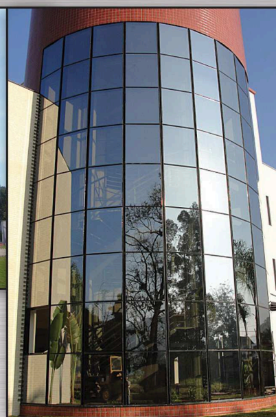
Fachada linha Cittá Due com vidro laminado refletivo verde.
