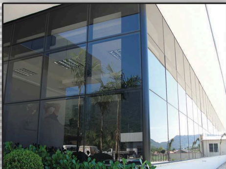
Fachada pele de vidro Estrutural Glazing com vidro fumê.
