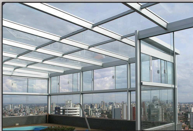
Cobertura de vidro sobre estrutura de alumínio com fechamento das laterais em vidro temperado incolor.
